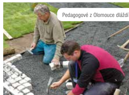
Skládání dřevěného lemu
